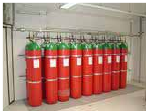
Impianto a gas inerti (es.: argon IG-02)
