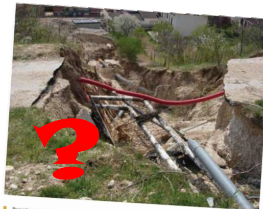
Paganica, zona acquedotto Paganica, aqueduct area
