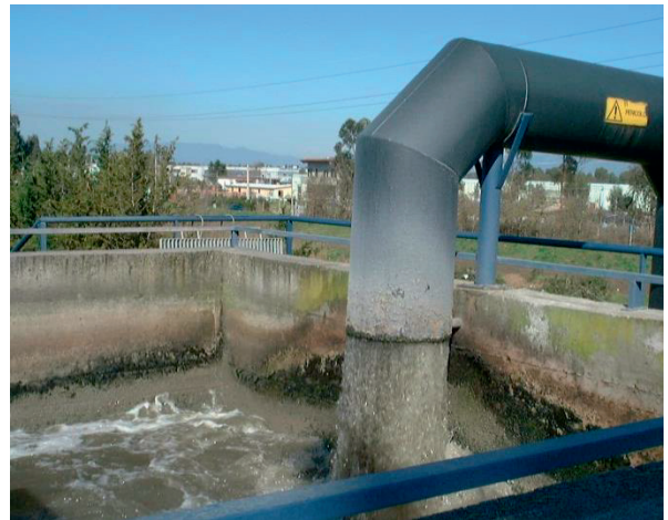
Fig. 24 - Getto in vasca di sedimentazione
