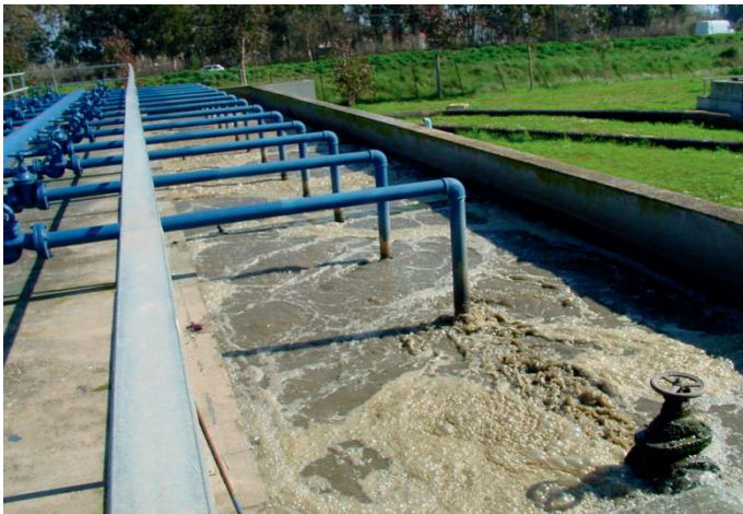
Fig. 23 - Bacino di ossidazione con diffusori sommersi
