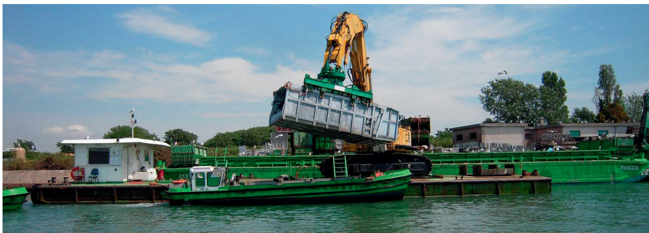
Fig. 6 - Scarico della chiatta (Fonte: www.veritas.it )
